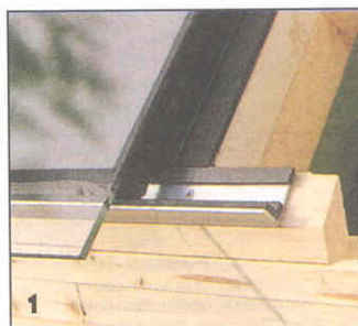
Здесь хорошо видно крепление стеклопакета к стропилам. Важное значение имеют резиновые уплотнители на уголке и выступающее верхнее (кроющее) стекло стеклопакета.
