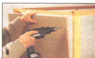
Дно вольера кладут в фальцы поперечных брусьев и привинчивают его шурупами.
