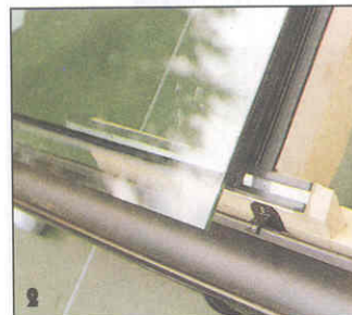
Монтаж водосточного желоба под свесом остекления. При необходимости кронштейны для крепления водосточного желоба можно установить на шурупах заранее. Желоб же можно навесить, завершив остекление.
